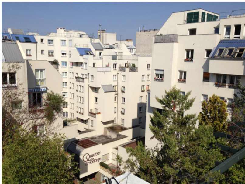
Jean-Claude Bernard, Quartier de l'Horloge, 1970-1979 Area inteiramente reconstruída no entorno do Beaubourg
