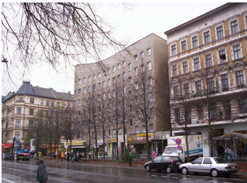
Rua de Kreuzberg restaurada, com prédio do Arq Álvaro Siza ao meio: “Bonjour Tristesse”
