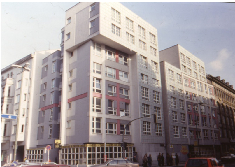
IBA: Edifício residencial na Friedrichstrasse, Arq. Peter Eisenman.
