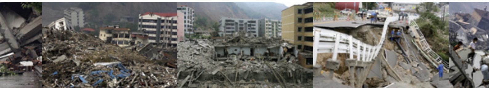
Terremotos na China, em 2008 e 2010, que provocaram o desmoronamento das chamadas casas e escolas de areia
