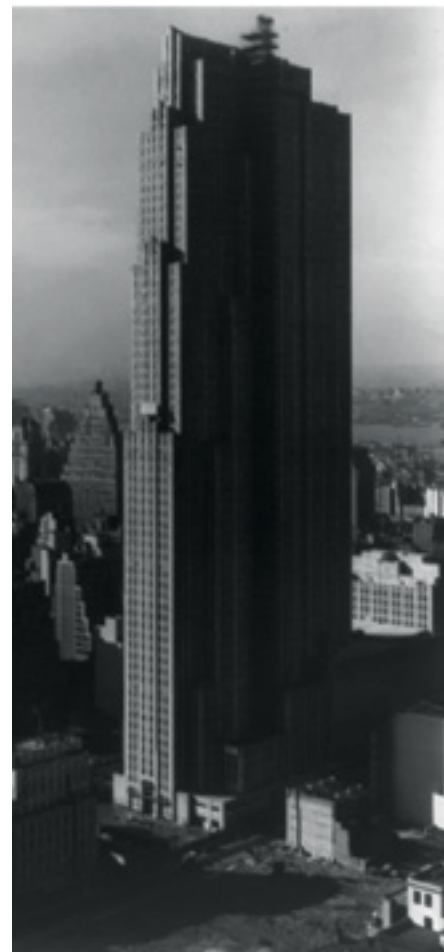
Rockefeller Center, em construção
