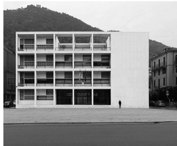
Terragni , Casa do Fascio , Como, Itália, 1932-36. Obra-prima de purismo formal para residência de jovens militantes do Fascio. Rigor geométrico levado ao extremo: planta quadrada, fachadas retangulares perfeitas, empena na proporção áurea e painel com palavras de ordem e retrato de Mussolini.
