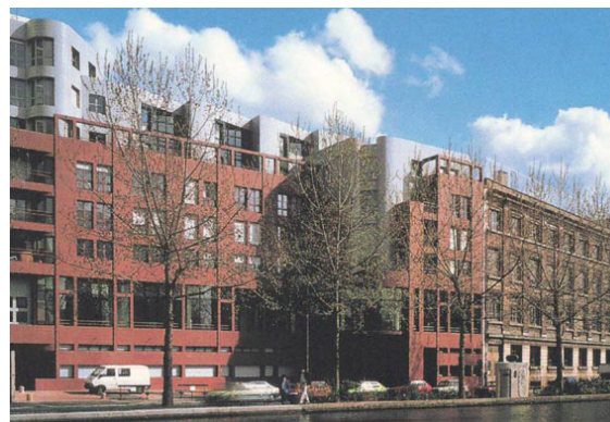
Antoine Grumbach , Prédio residencial no Quai de Jemmapes, Paris, 1985. Outro exemplo de arquitetura “discreta” do autor de A arte de completar as cidades .
